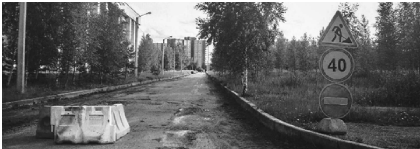
Начало ремонта дорожного покрытия около здания Института химии.
